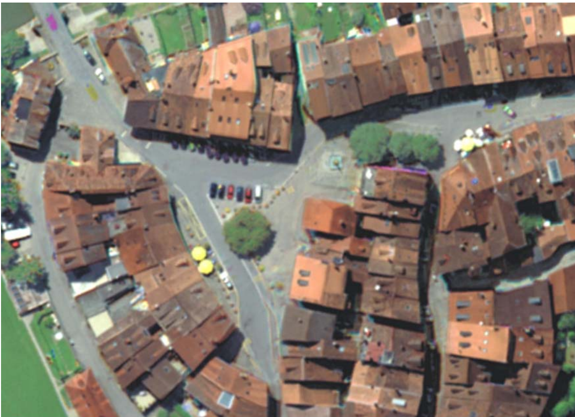
situation actuelle de la Place du Petit-Saint-Jean vue aérienne fig. 11
